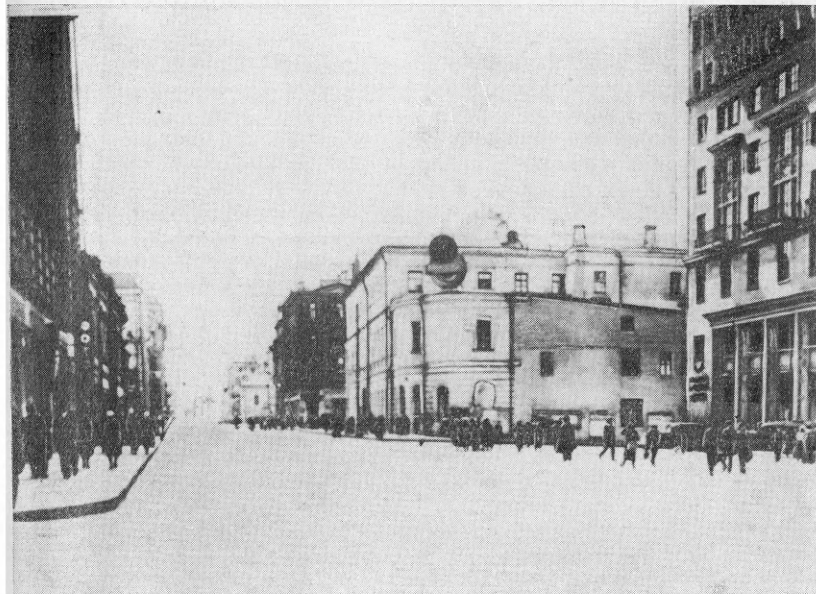
Рис. 14. Ул. Горького в Москве (от пл. Пушкина до пл. Маяковского) до ее расширения
