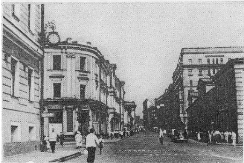
Р и с. 13. Здание Моссовета до передвижки и надстройки. Ул. Горького до ее расширения и передвижки здания Моссовета (на переднем плане слева виден его угол)
